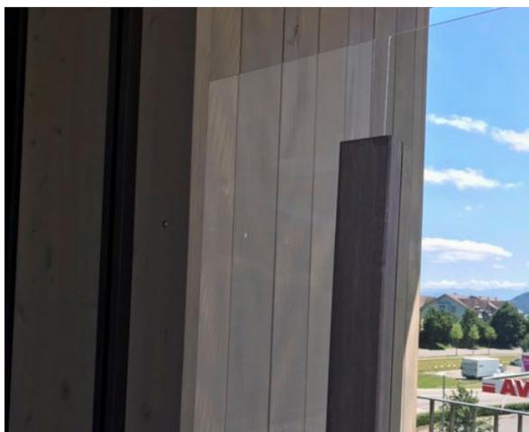
Der optimale Schutz wird mit einer Verbreiterung erreicht.
